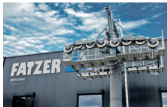
安装在11.40米高的支架上的轮组
