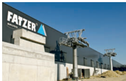
测试缆车设施施工现场，左侧图中是机房
